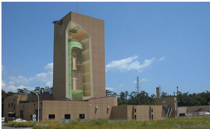
**図3 タンデム加速器建家と加速器本体のイメージ図** 地上約45メートルの建家にタンデム加速器が設置されている。そこで生み出された原子核ビームの加速エネルギーを、超伝導ブースターにより2～4倍に増強する。
